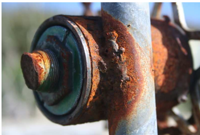
Figura 2 - Peça corroída pelo contato entre materiais diferentes Fonte: WIKIPEDIA
