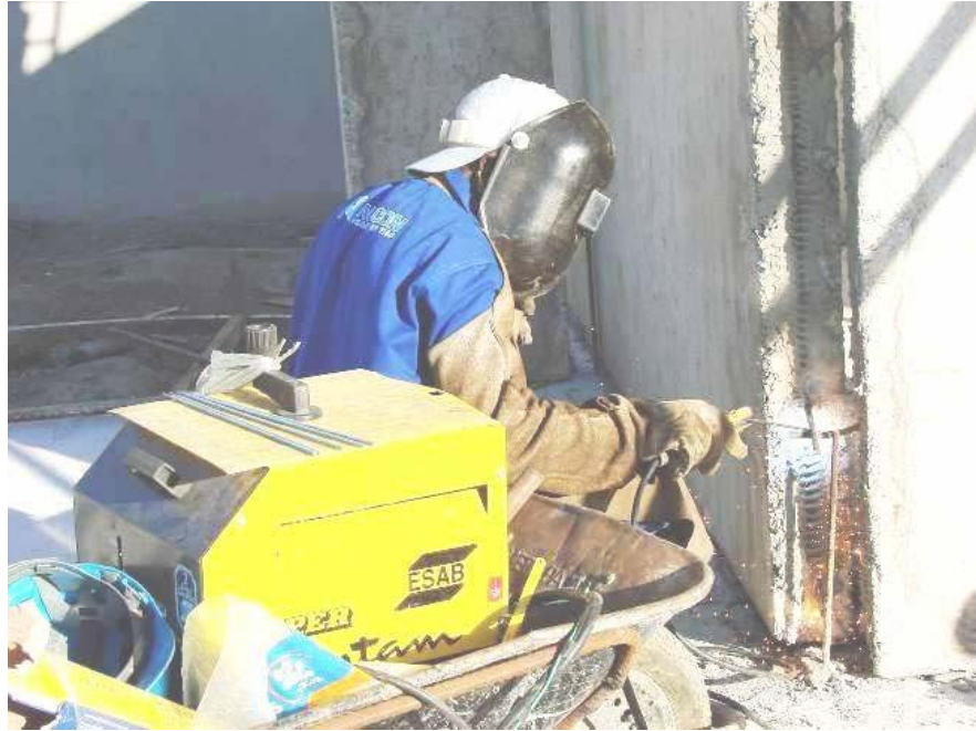
Figura 5 – Atividade de solda, gerando a dispersão de fumos metálicos no ambiente. Fonte: SESI
