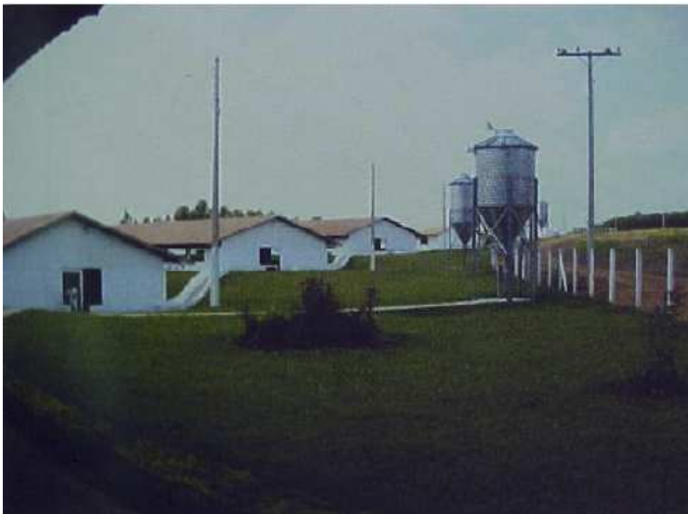
Figura 9 - Cercas de proteção utilizadas para delimitar áreas Fonte: SARTOR; SOUZA; TINOCO, 2004.
