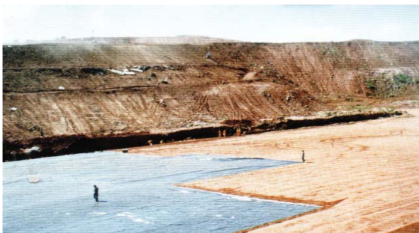
Figura 7: Geomembranas sintética parcialmente instalada Fonte: ASFAMAS, 2000.
