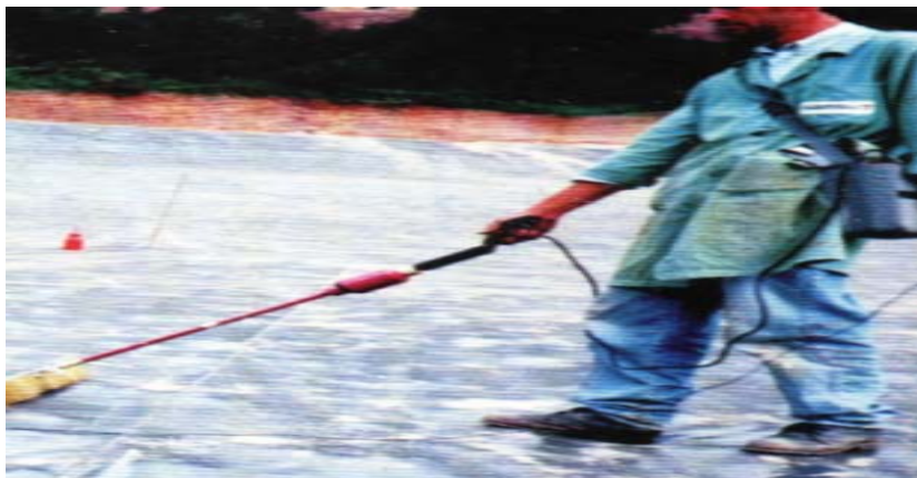
Figura 5: Teste de qualidade da impermeabilização Fonte: ASFAMAS, 2000.
