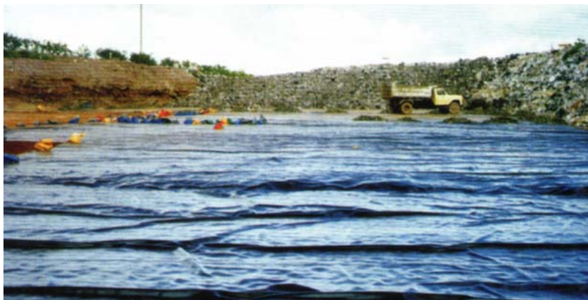
Figura 8: Geomembranas sintética totalmente instalada Fonte: ASFAMAS, 2000.
