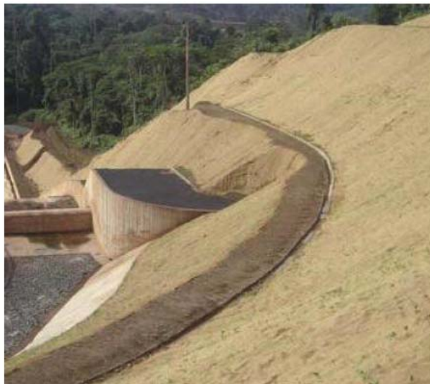
Figura 7 – Biomanta de fibra de coco aplicada em talude Fonte: (SILVEIRA, 2008).
