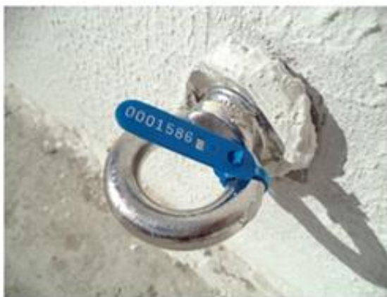
Figura 2 – Dispositivo de ancoragem em aço inox Fonte: (GROSSI, 2017)
